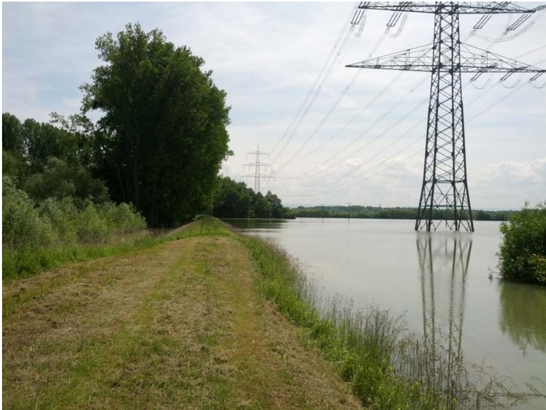
Abb. 6: Eingestaute Hochwasserrückhaltung Daxlander Au.
